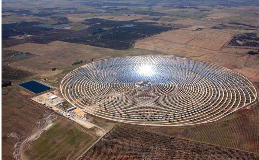
*Figura 4. Campo de helióstatos de la central Gemasolar en Sevilla*
