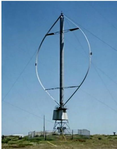
Figura 1.2. Aerogenerador de eje vertical con rotor Darrieus
