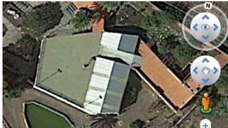
Figura 14. Ubicación de los paneles y las baterías.
