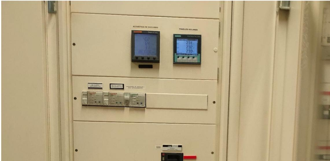
Figura 11. Analizadores en el CGBT. Fuente: Elaboración propia
