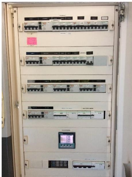
Figura 11. Analizador de red EDF\_MANTENIMIENTO. Fuente: Elaboración propia
