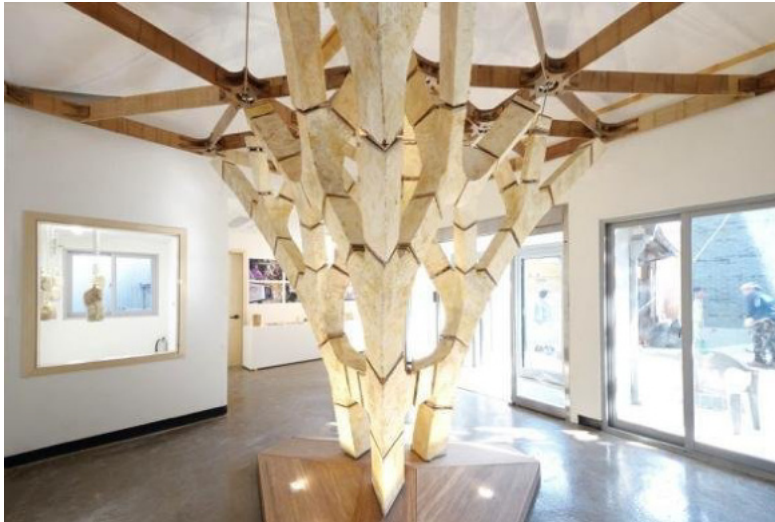
Figura 1.11: Estructura de micelio creada para la exposición de arquitectura y urbanismo bienal de Seúl. Fuente: Heisel et al.
