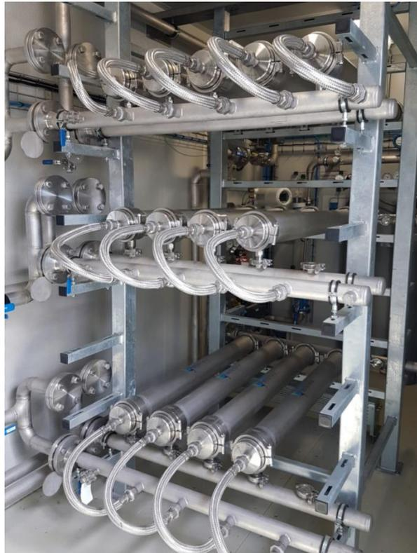
Figura 30: Módulo de membranas (Bright Biomethane)
