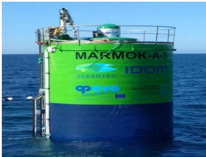
Ilustración 19: Convertidor undimotriz flotante offshore [13].
