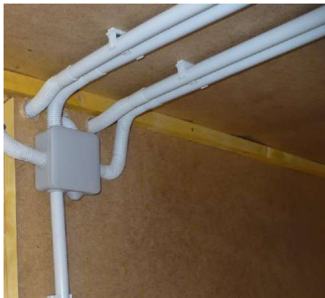
Figura 24. Ejemplo de instalación de cableado en tubos de PVC
