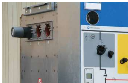
Colocación de ormalink
