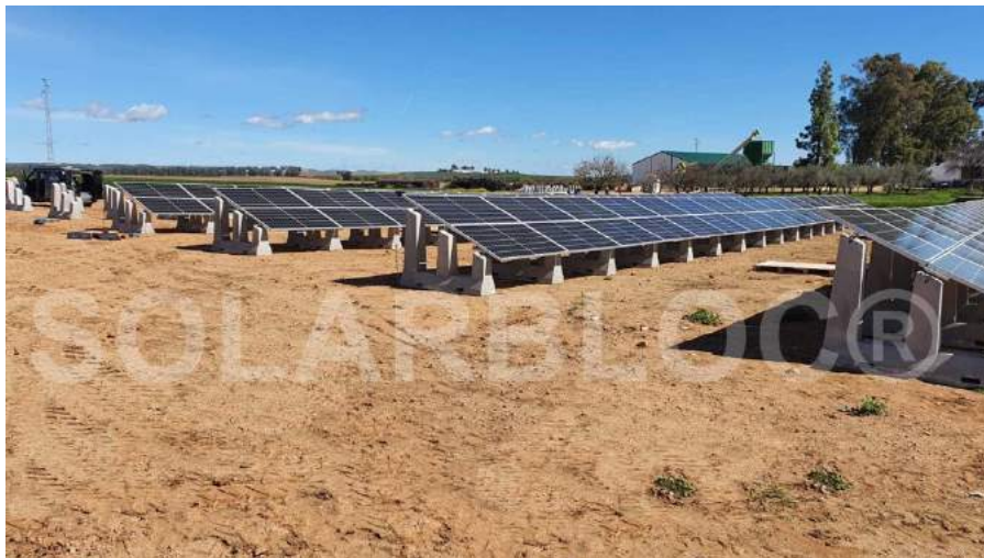
Figura 5: Ejemplo de una instalación con sistema de sujeción Solarbloc. Fuente: Solarbloc
