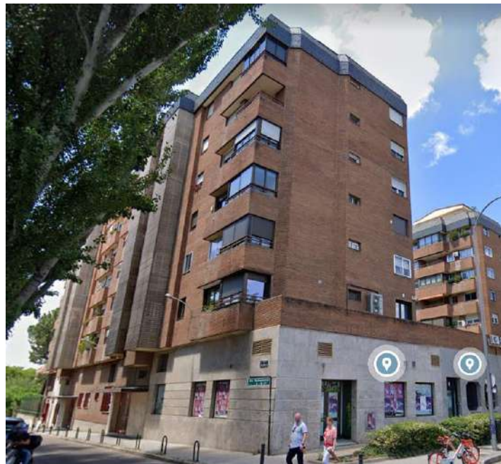
Figura 20. Vista lateral de los portales A y B
