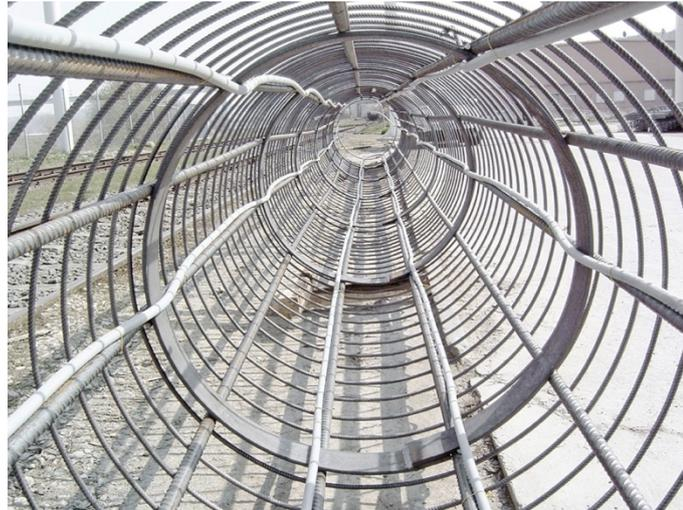
*Ilustración 6: Tubos colocados paralelamente a los pilotes (Tectónica, 2023)*
