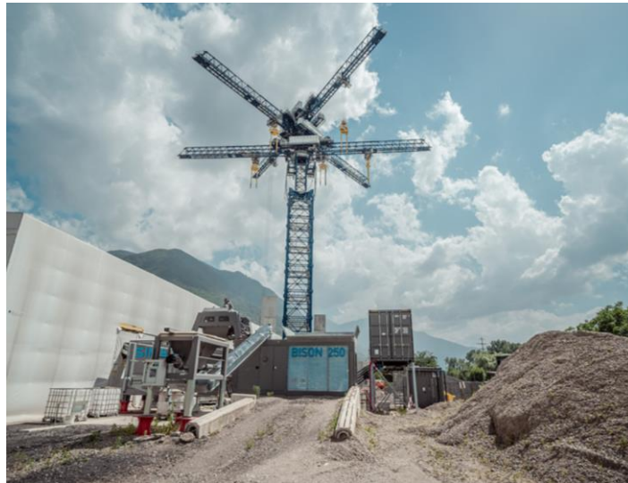
Ilustración 2.2: Fotografía de la torre EV1 una vez finalizada su construcción en Julio de 2020
