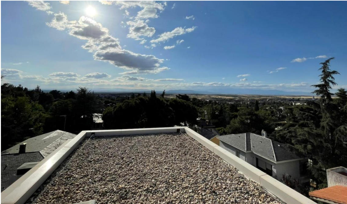
Ilustración 15: Imagen de la cubierta donde se realizará la instalación
