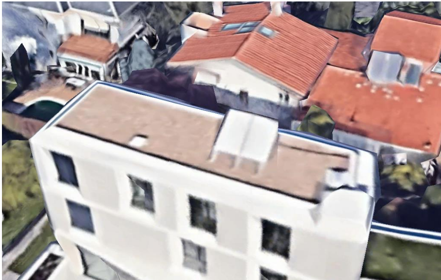
Vista satélite de la vivienda en la que se realiza la instalación
