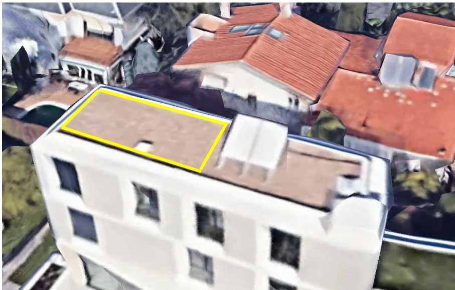
Ilustración 14: Imagen detalle del tejado donde se realizará la instalación
