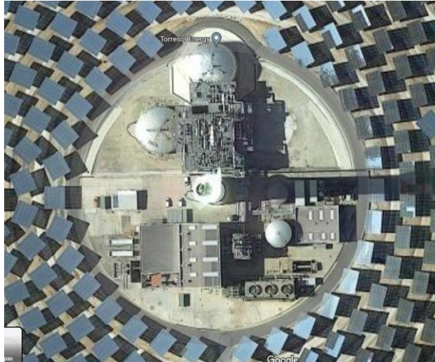
Figura 7. Vista superior de la central de Gemasolar en Sevilla [6]
