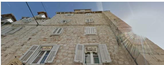
Figura 19. Fachada del edificio seleccionado.
