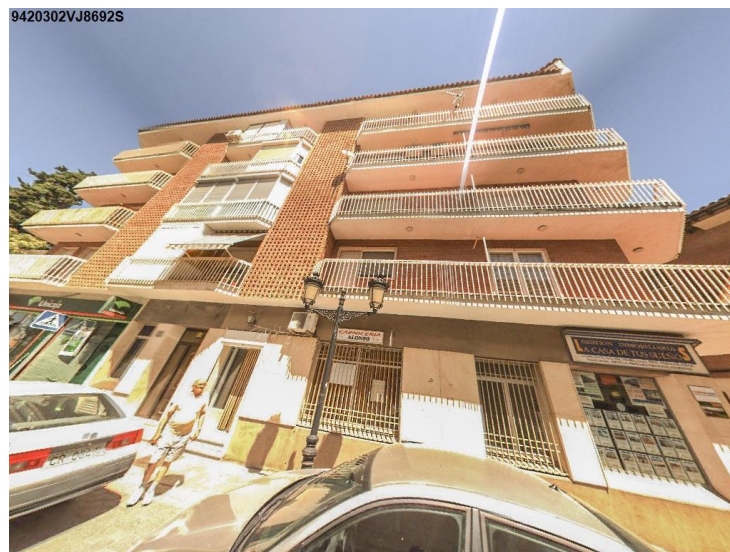
Ilustración 1. Fachada del edificio. Fuente: Catastro nacional
