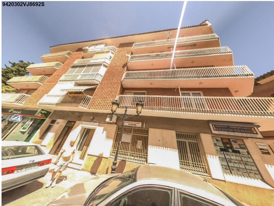
Ilustración 7. Fachada del edificio. Fuente: Catastro nacional
