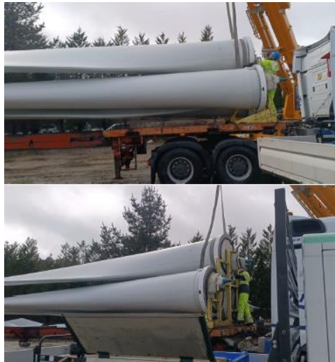
Ilustración 14 Transporte de palas. (EGPE, 2023)
