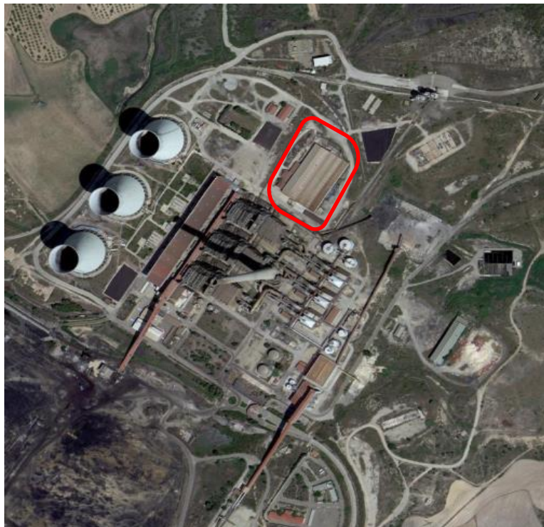
Ilustración 5 Vista de la antigua Central Térmica de Andorra. (Google Maps, 2023)
