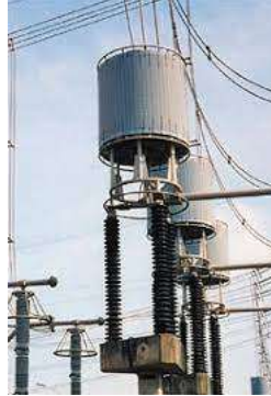
Figura 12: Bobina de bloqueo (FuenteVica T&D)
