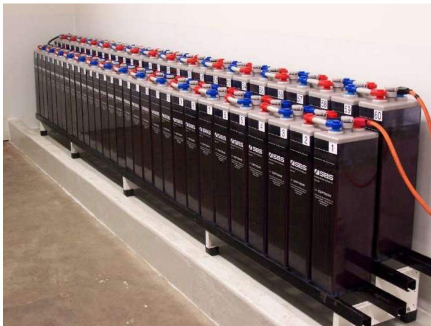
Figura 14: Instalación de baterías (Fuente: Solarbex)
