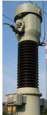
Figura 9: Transformador de intensidad (Fuente: Wikipedia)
