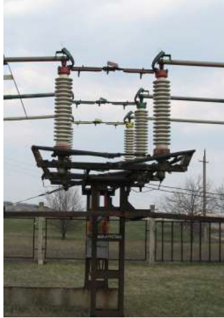
Figura 7: Seccionador instalado en una subestación (Fuente:Wikipedia)
