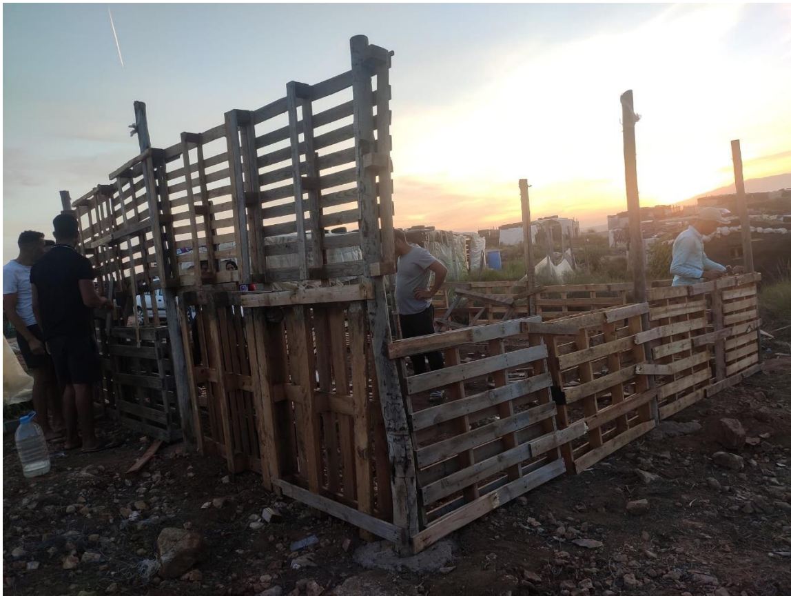
Imagen 4: Construcción de la escuela en el Asentamiento de El Hoyo
