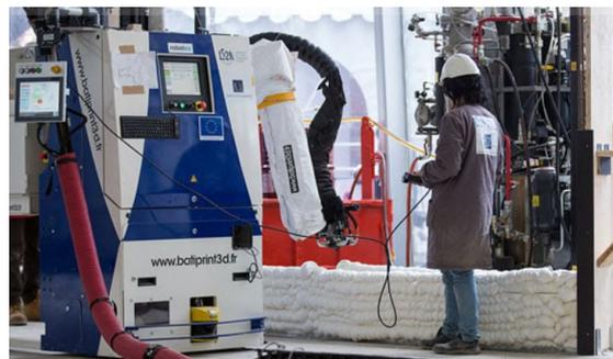
Figura 2.4: Impresora 3D de cemento empleada para construir edificios [32]
