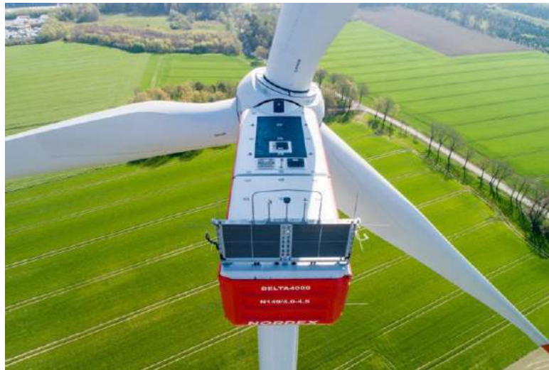
Figura 45. Aerogenerador Nordex N149/5.X (Nordex, s.f.).
