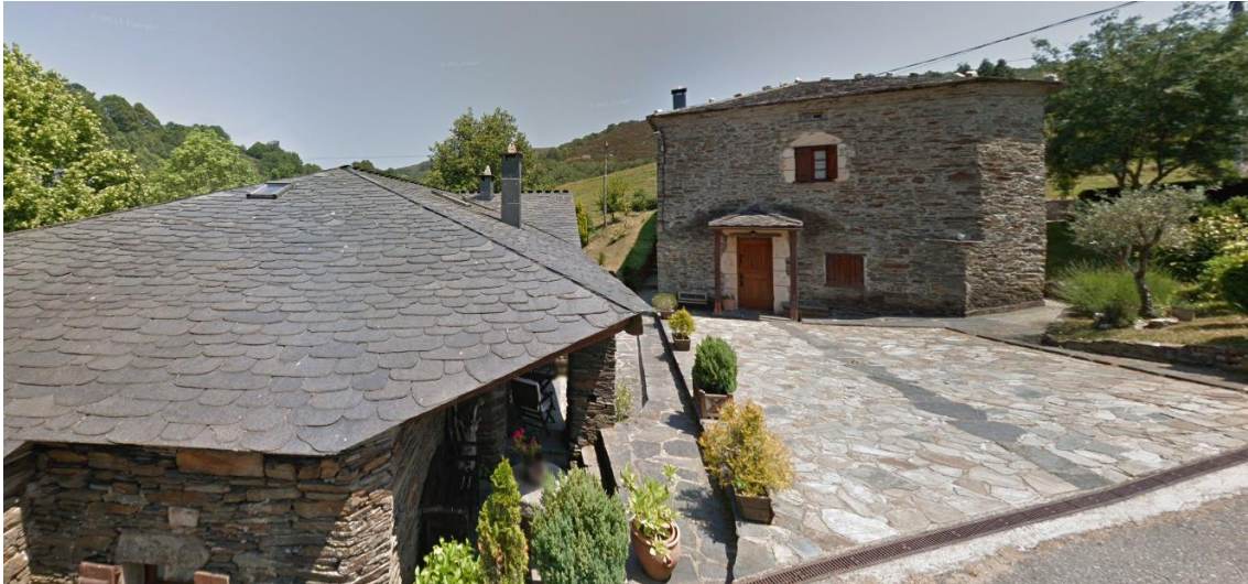
Ilustración 36. Fachada de la vivienda familiar. Fuente: Google Maps
