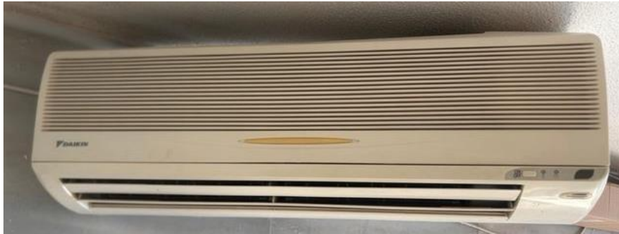
Ilustración 10 - Aire Acondicionado AC Daikin Industries FTYN35CVMB9
