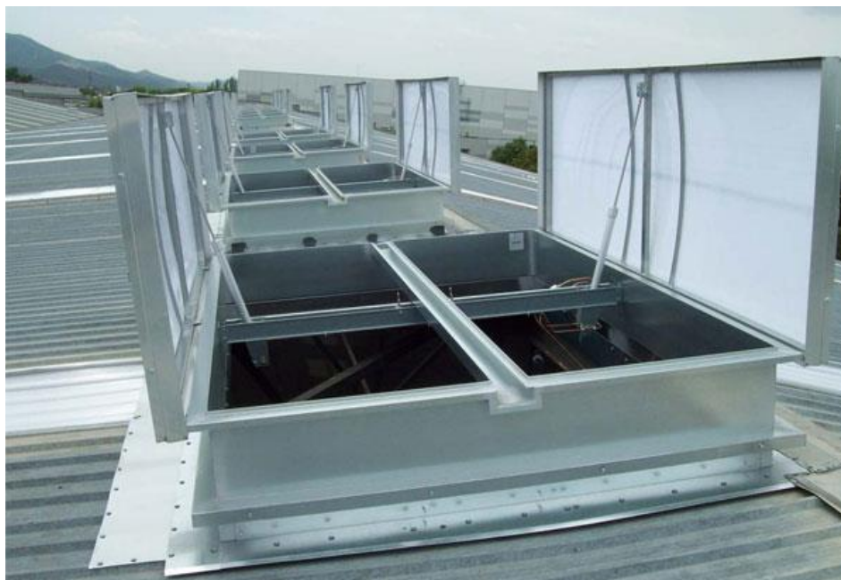
Ilustración 5: Exutorio de apertura automática de ventana.
