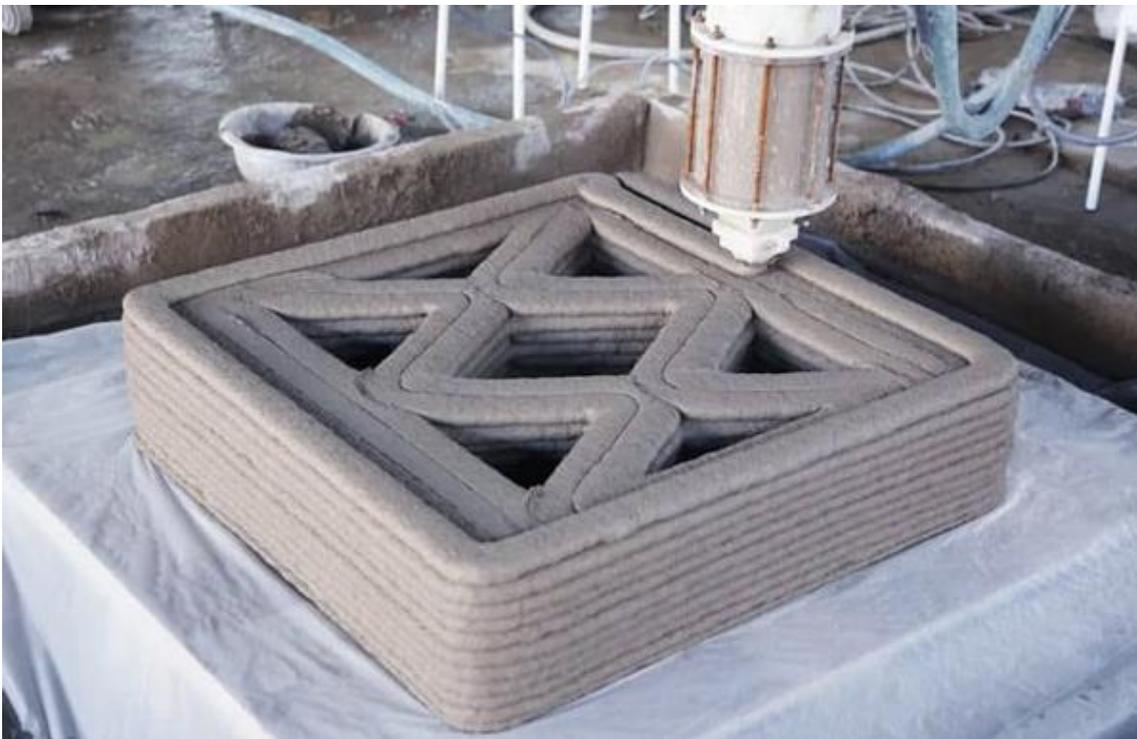
*Ilustración 51. Impresión 3D con hormigón [69]*
