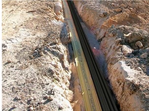
*Figura 47: Zanja subterránea para cables [36].*
