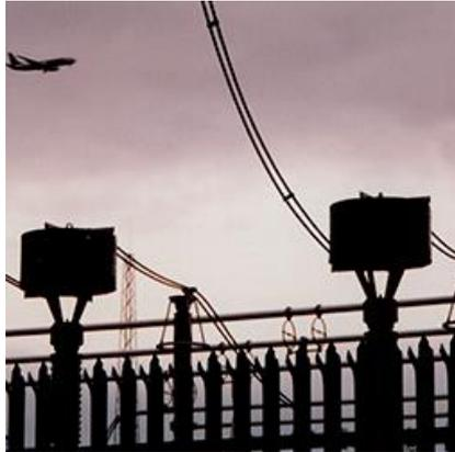
*Figura 44: Bobinas de bloqueo [34].*
