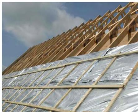
Figure 1.17: Ejemplo de aislamiento por sistema multicapa reflectivo en cubierta.
