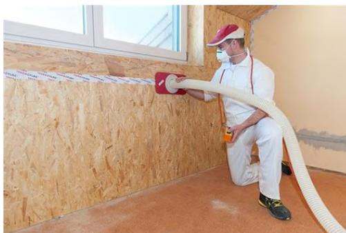
Figure 1.14: Ejemplo de aplicación de aislamiento térmico por insuflado en cerramiento con cámara de aire. Fuente: Thermofloc España y Portugal [209].
