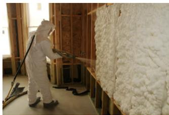
Figure 1.2: Espuma de poliuretano proyectada en muro. Fuente: Poliuretano y Poliurea [187].
