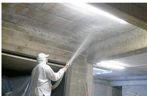
Figure 1.15: Ejemplo de aislamiento de techo con un sistema proyectado de espuma de poliuretano. Fuente: Ecogreenhome [104].
