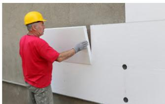
Figure 1.3: Paneles de poliestireno expandido (EPS). Fuente: Placomat [185].
