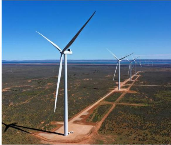
*Fig. 14: Aerogenerador de eje horizontal de 3 palas [21].*
