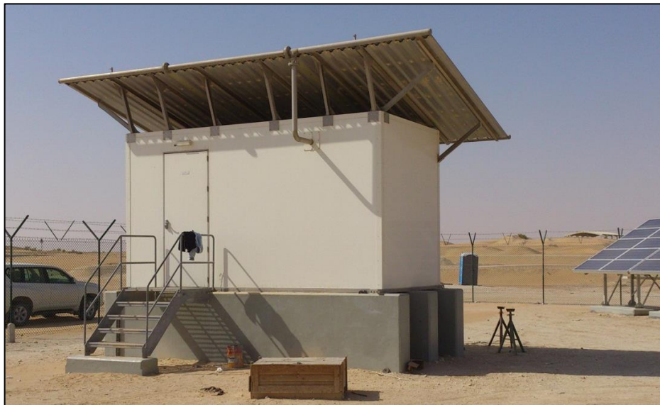
Figura 8. Ejemplo de tejado externo, adicional al techo de la caseta. (Intertec, 2016)
