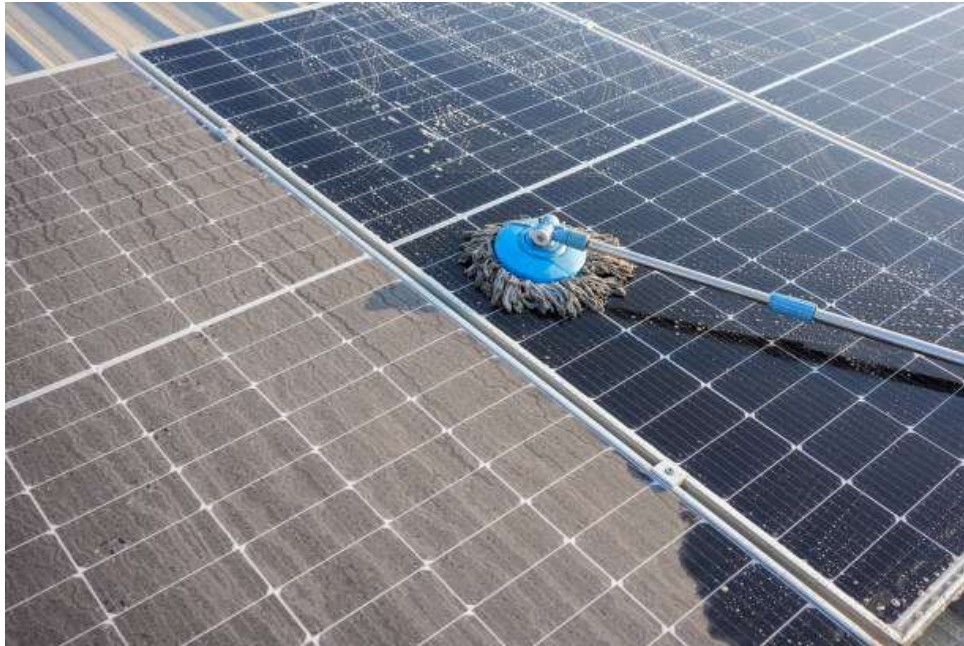
Ilustración 28: Limpieza de placas solares.
