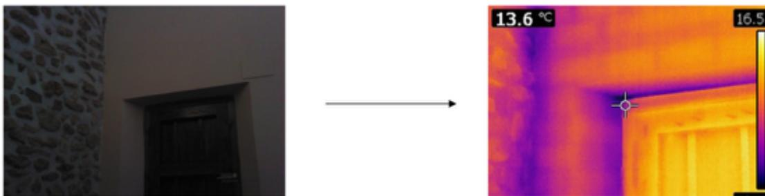
*Figura 13: Análisis termográfico – Puente térmico en dintel de puerta [Fuen25]*
