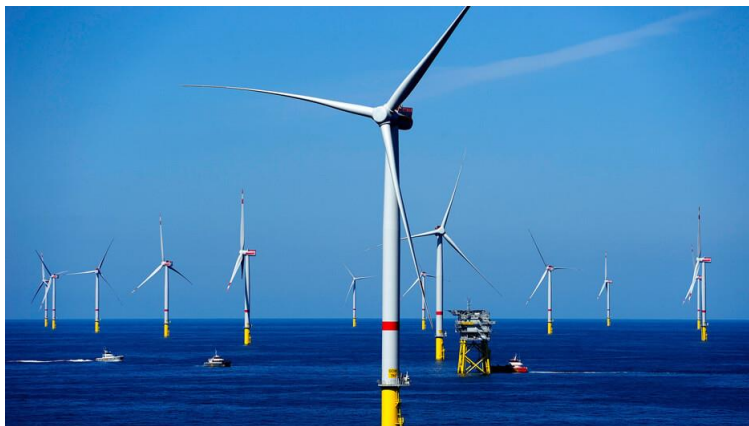
Ilustración 2. Parque eólico offshore [8].
