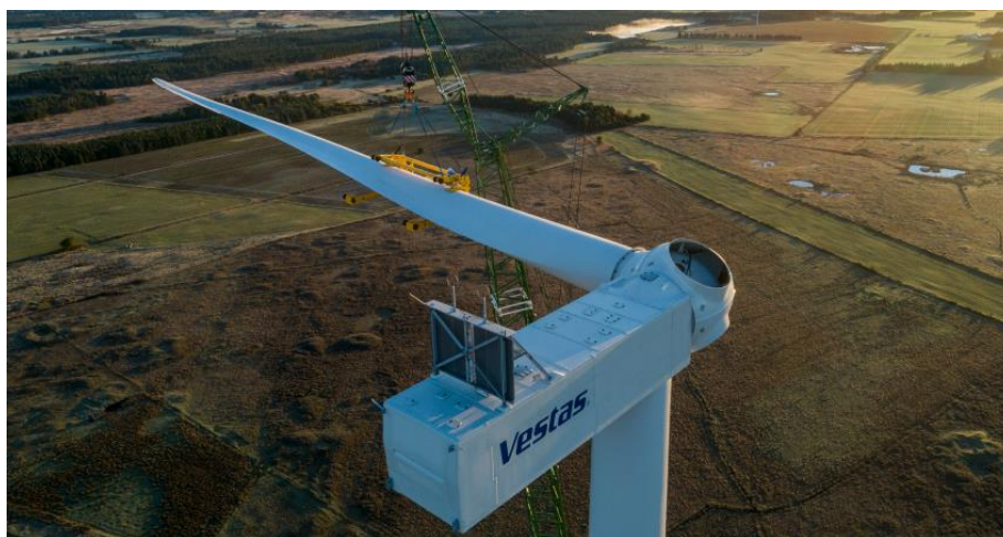
Ilustración 25. Góndola y palas del aerogenerador V172 de Vestas.
