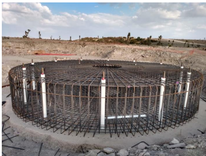
Ilustración 27. Cimentación de un aerogenerador en proceso de construcción.
