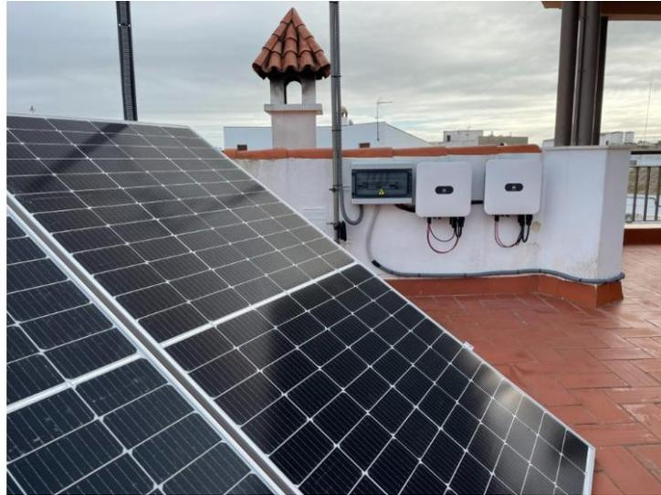
*Ilustración 35. Inversor en instalación de autoconsumo (Fuente: Ivantel Energy)*
