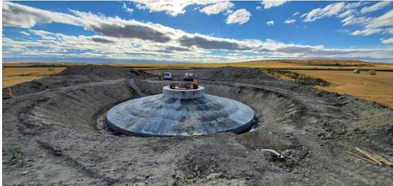
*Figura 74: Cimentación superficial circular de acero y hormigón.*
