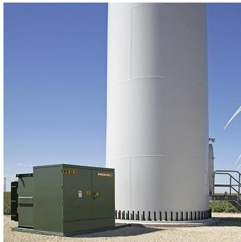
*Figura 29: Transformador de un aerogenerador en una base externa [57].*
