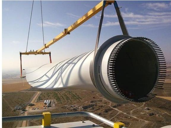
*Figura 21: Pala de un aerogenerador [49].*
