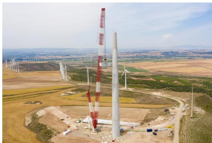
*Figura 17: Plataforma de montaje de un aerogenerador (Interempresas) [21]*
