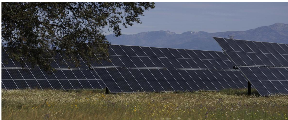
Figura 15. Planta fotovoltaica Talayuela II, de Statkraft [Statkraft]
