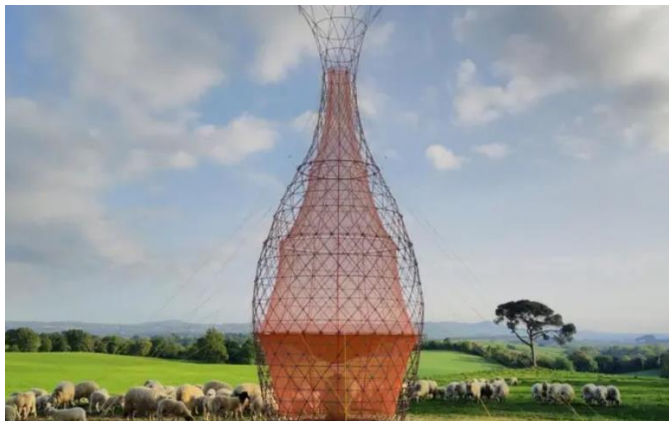
Figura 6. Torre Warka instalada en Italia (BBC).
