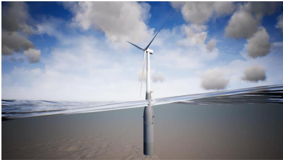
*Ilustración 6: Aerogenerador con plataforma tipo Spar*
