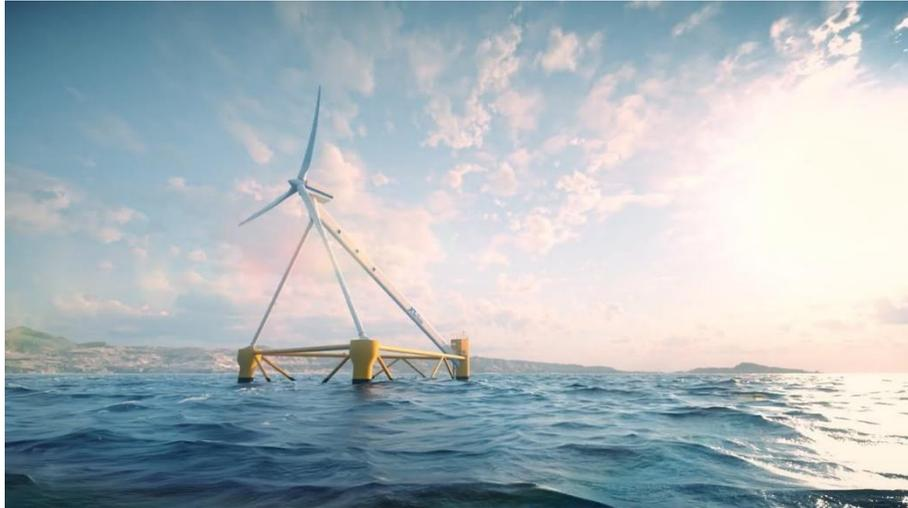
*Ilustración 7: Aerogenerador flotante TLP*
