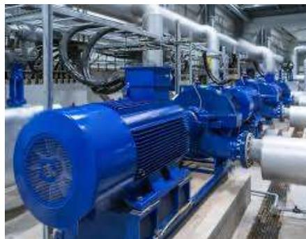
Figura 11: Bombas industriales para recirculación de fluidos. Fuente: Asimer Group.
