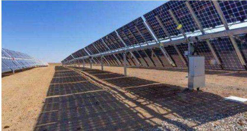
*Ilustración 16: Módulos solares bifaciales instalados en 2V (Fuente: Univergy Solar)*
