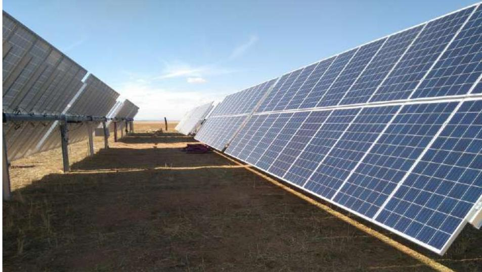
*Ilustración 22: Estructura de seguidor 1 eje 2V (Fuente: AlphaTracker)*
