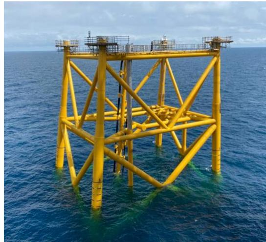
*Ilustración 39: Esquema de la plataforma tipo jacket*
