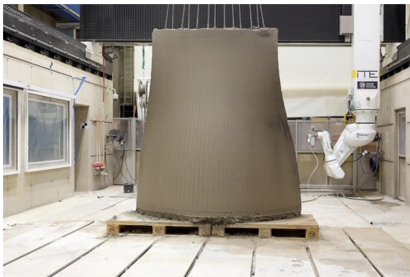
Figura 9. Ejemplo del Uso de la Impresión 3D en Construcción [25].
