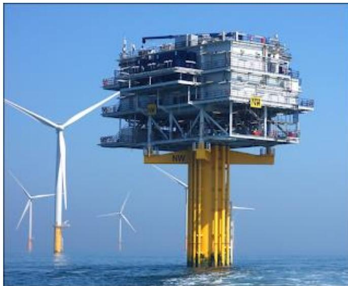
*Figura 32: Subestación offshore típica de un parque eólico offshore. (Energías Renovables Marinas, 2019)*
