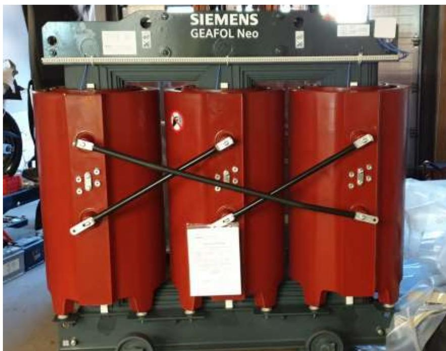
Figura 47. Transformador Siemens Energy Gaefol Neo
