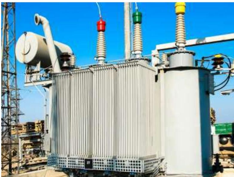
Figura 57. Transformador de potencia ONAN
