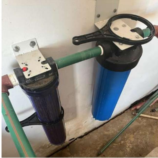
Figura 6.12: ESistema de filtrado doble empleado en el hospital
