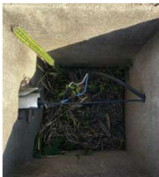
Figura 8.8: Estado actual del cableado de los motores
