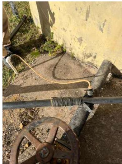
Figura 7.9: Adición de la mezcla del hipoclorito de sodio
