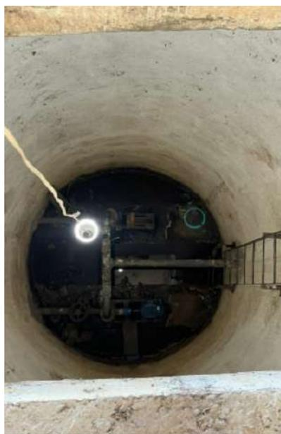
Figura 7.5: Motores y bombas de captación]
