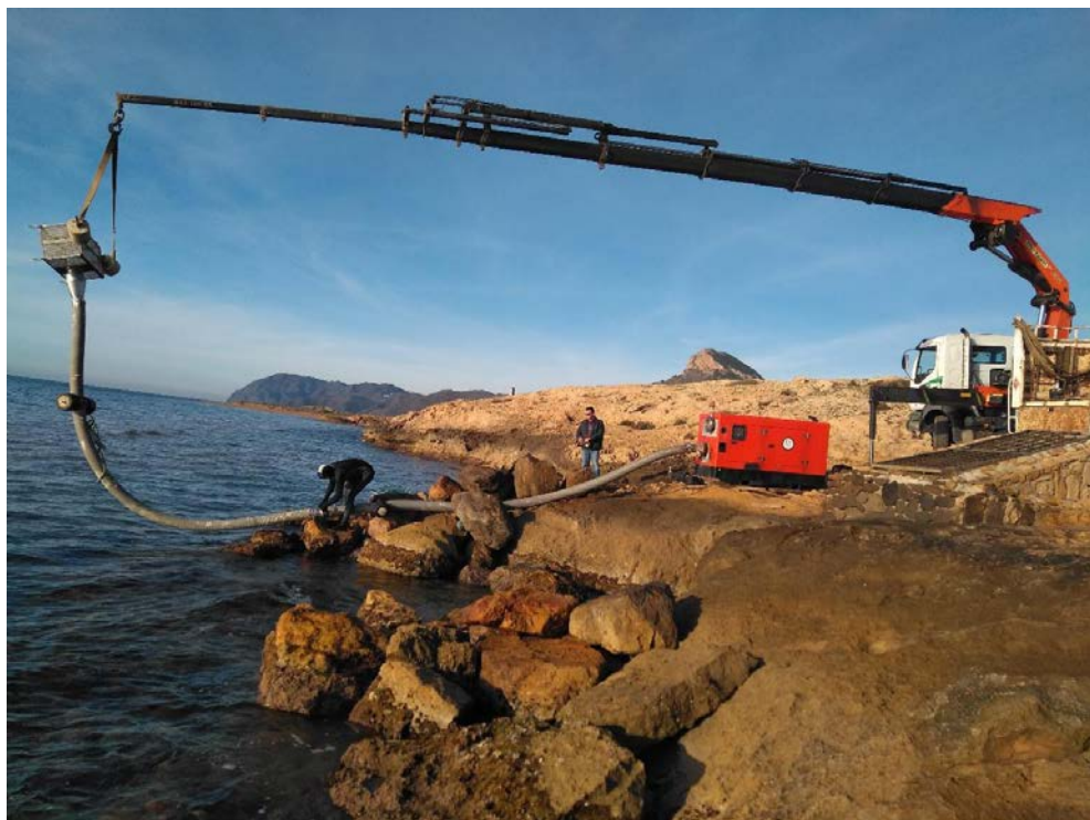
Figura 5: Sistema de bombeo empleado en la actualidad mediante equipos alquilados de forma puntual. Fuente: Óscar Manuel Moñino Moral
