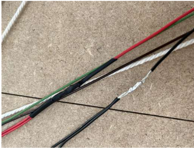
Figura 6.12: Soldadura de estaño
