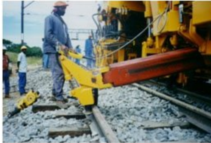
Figura 2. Tercer dispositivo de elevación de carril para desvíos
