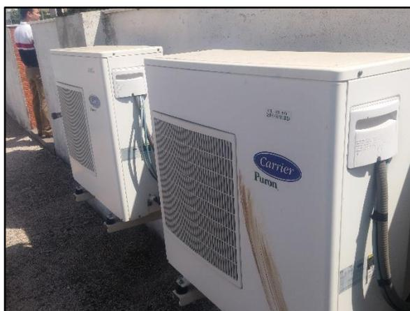
Figura 48. Bombas de calor con refrigerante R-22
