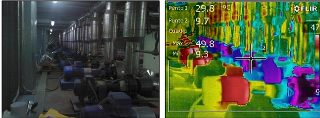
Figura 54. Termografía de bombas de impulsión
