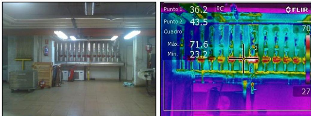
Figura 55. Termografía de colectores
