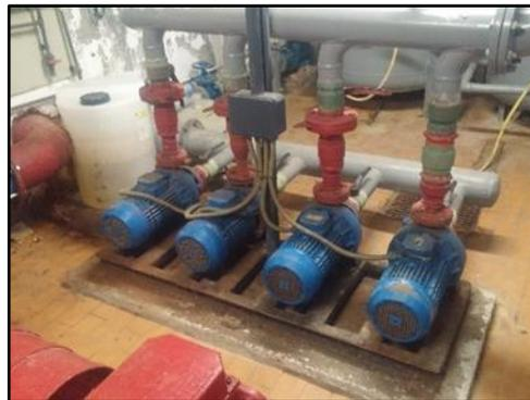
Figura 19. Bombas gemelas circuitos de calor
