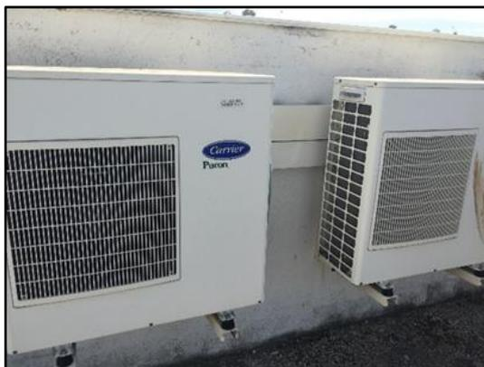
Figura 20. Bombas de calor situadas en la cubierta
