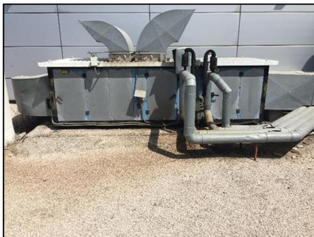
Figura 25. UTA situada en la cubierta
