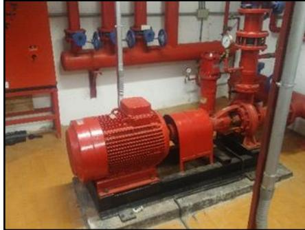
Figura 18. Bomba circuito de calor
