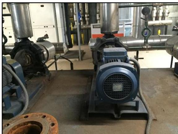
Figura 24. Bomba circuito de frío
