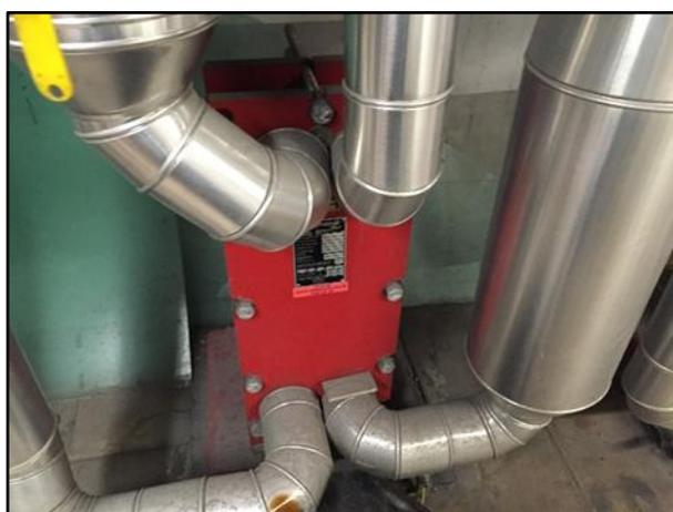
Figura 58. Intercambiador de calor
